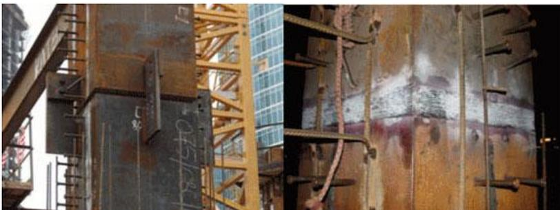
**Рис. 2.1.2 - Стык элементов сварных колонн до сварки и после сварки**
